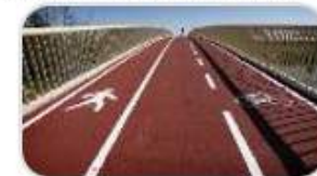
Carril Bici y paseo peatonal
